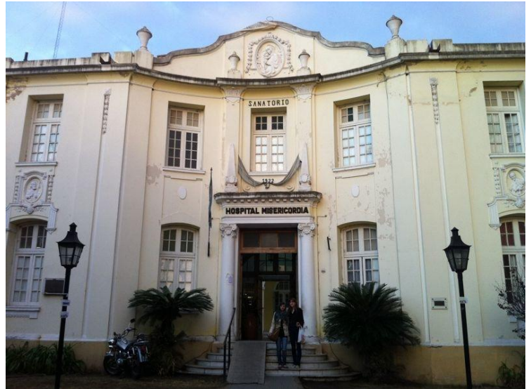
Entrée principale de l'hôpital Misericordia
