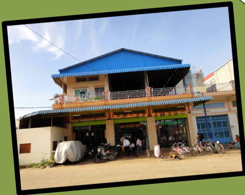
L'entrée du centre vue depuis la route
