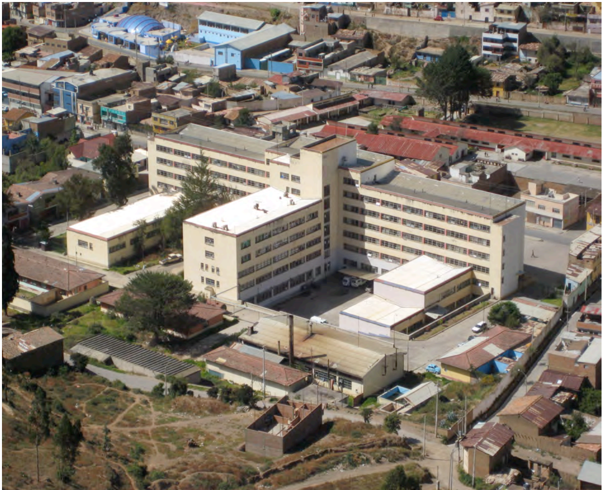
Image: hôpital de Tarma
