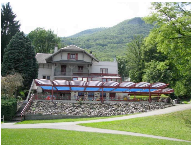
Le bâtiment central comprenant un dortoir, une infirmerie et un réfectoire)
