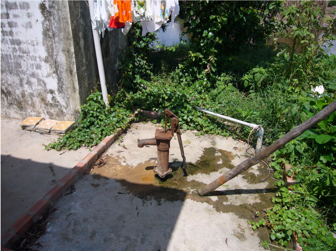
Un puits qui fournit de l'eau propre
