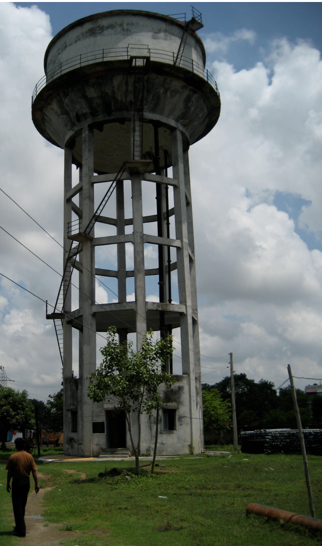
| Le château d'eau
