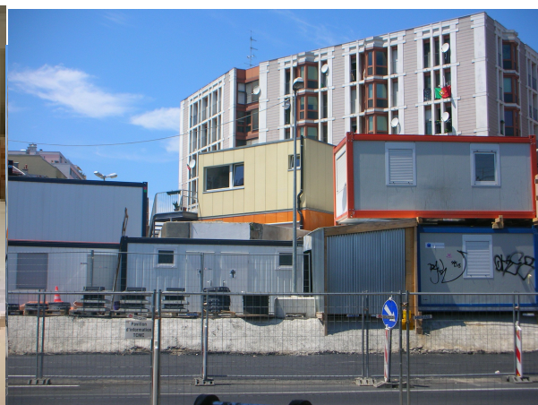
Quai 9 caché par les travaux
