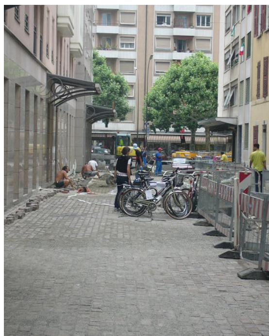
Chantier de la rue de Carouge, Genève
