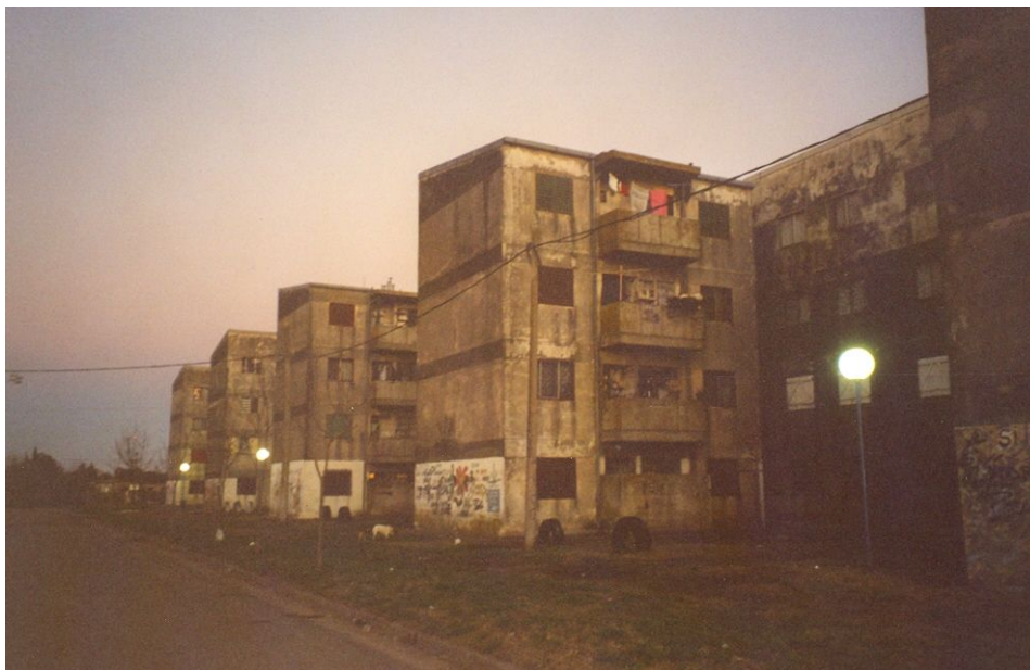
Figure 13 : quartier défavorisé de Firmat
