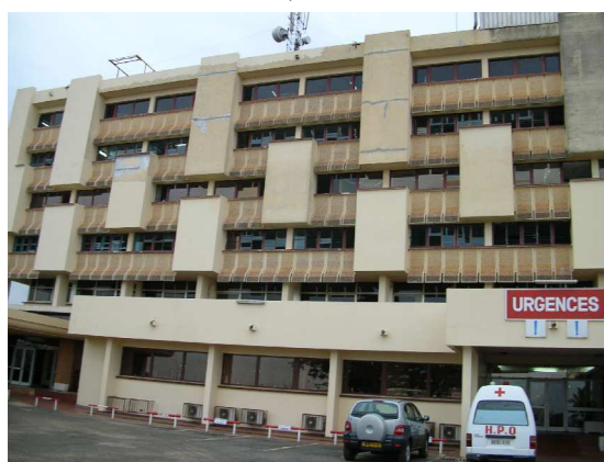
L'hôpital pédiatrique d'Owendo et ses places de parking vides (réservés aux médecins)...
