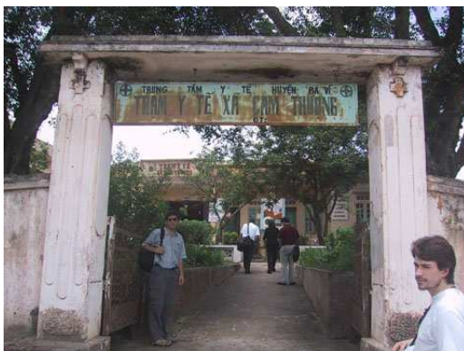
Entrée du poste sanitaire commun
