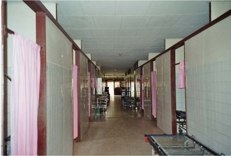
Corridor de la maternité
