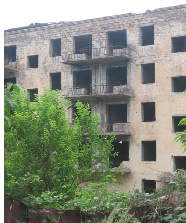
Immeuble de Chouchi
